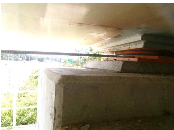
받침장치 연단거리 측정
