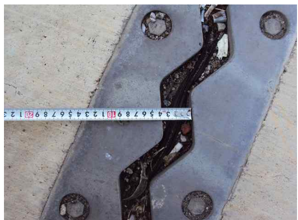
신축이음 이동량 측정
