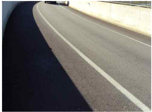
교면포장 S1 상태현황
